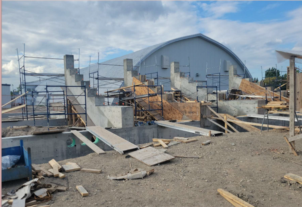
Démoulage et nettoyage des gradins. Vue vers l'ouest. Le 16 septembre 2025.
