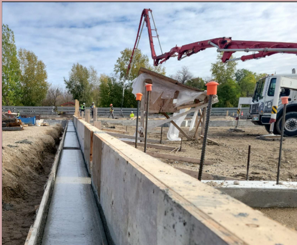
Coulage final des poutres, vue vers l'est. Le 15 octobre 2025.
